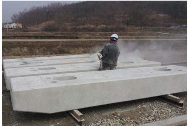
Precast 코핑 제작
